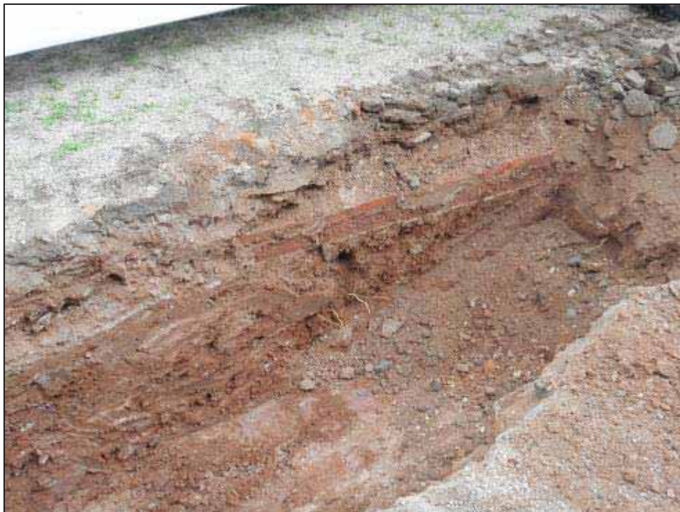
18. Servei elèctric en actiu cobert per maons.
