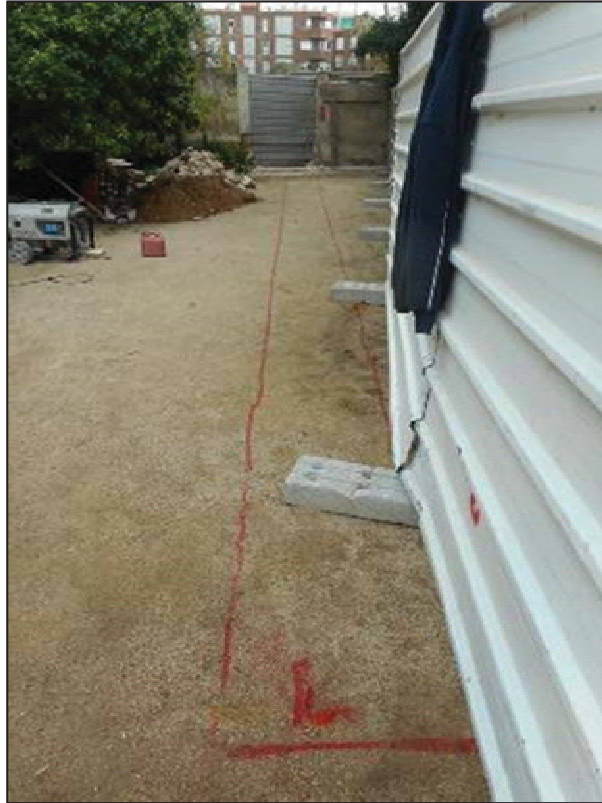
5. Projecció de la rasa dins el pati nord dins el tancat de la Torre Mitjans.
