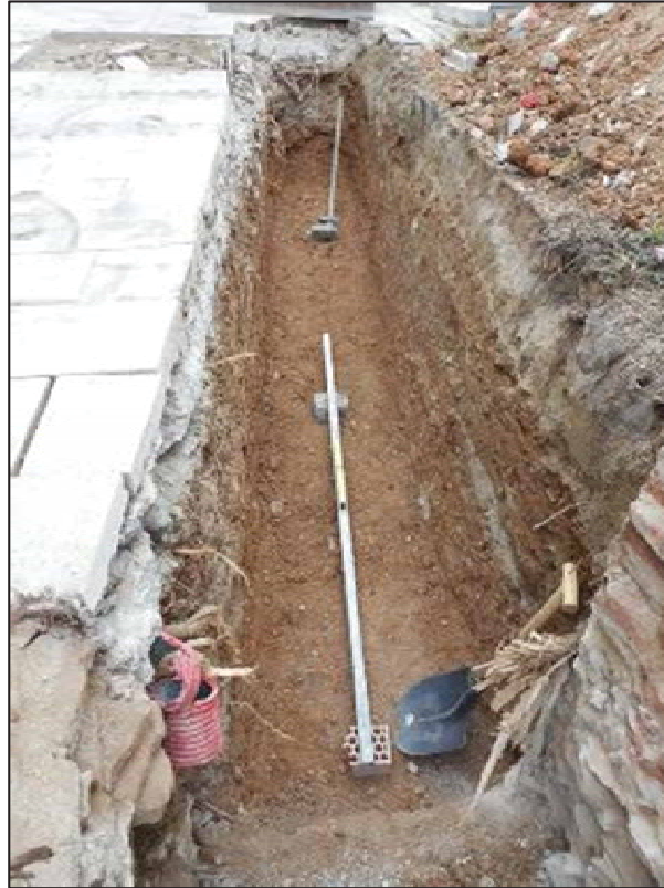
29. Finalització de les tasques de rebaix de terreny de la rasa.
