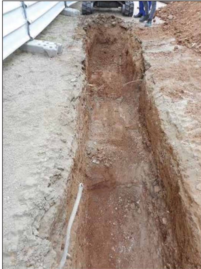
17. Màquina realitzant les tasques de buidat de la rasa.
