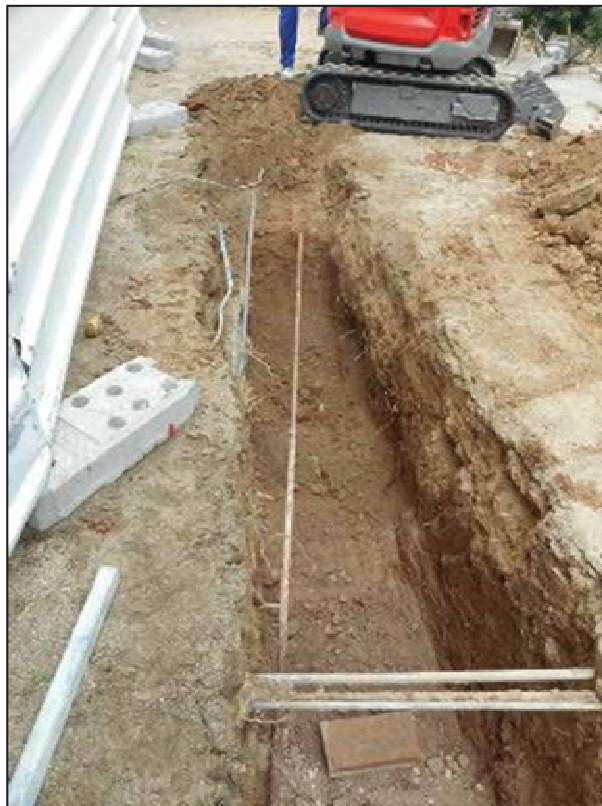
22. Tram final de la rasa. Presència de diversos serveis.
