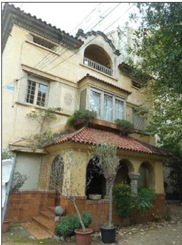
2. Façana principal de la Torre mitjans.
