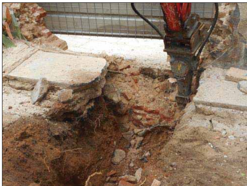
10. Desmuntatge de part del mur perimetral del tancat de la finca de la Torre Mitjans.
