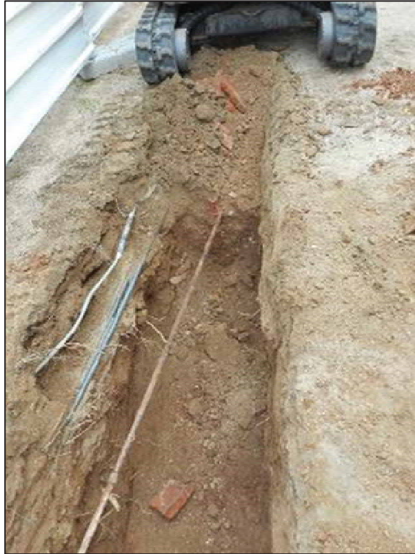
21. Tram final de la rasa. Presència de diversos serveis.
