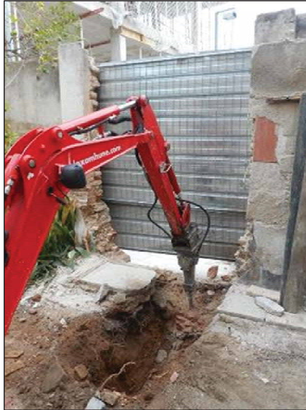
11. Desmuntatge de part del mur perimetral del tancat de la finca de la Torre Mitjans.
