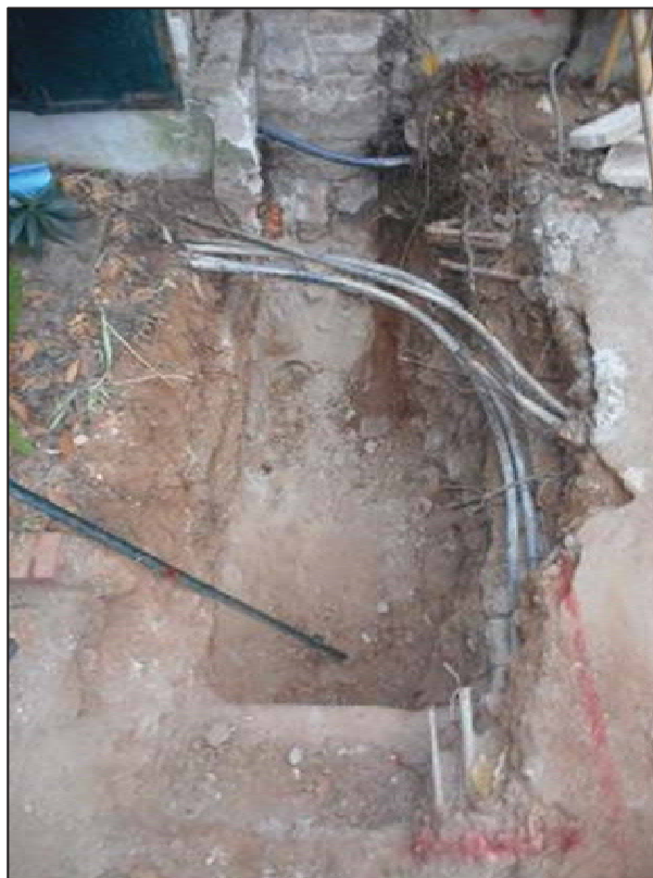
8. Detall del primer tram de la rasa, s'aprecien els serveis actius.
