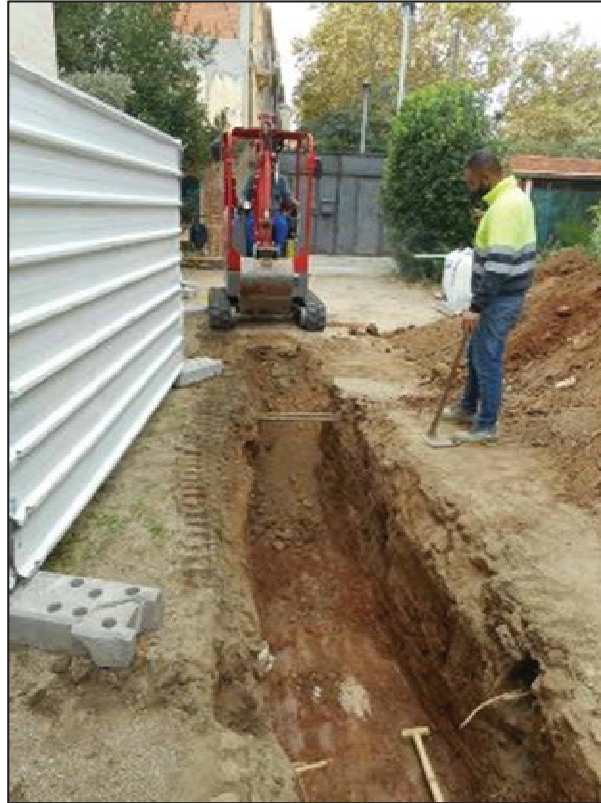
19. Màquina realitzant les tasques de buidat de la rasa.
