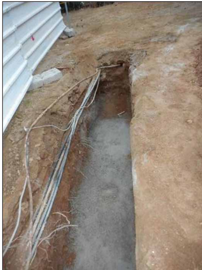
24. Tram final de la rasa
