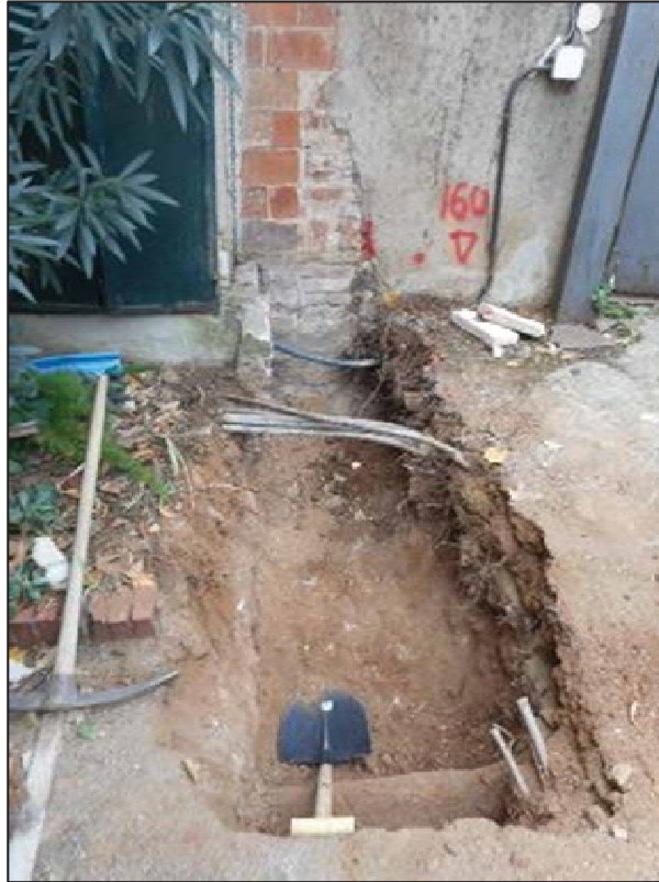
7. Tram inicial de la rasa, a tocar de l'entrada de la finca.
