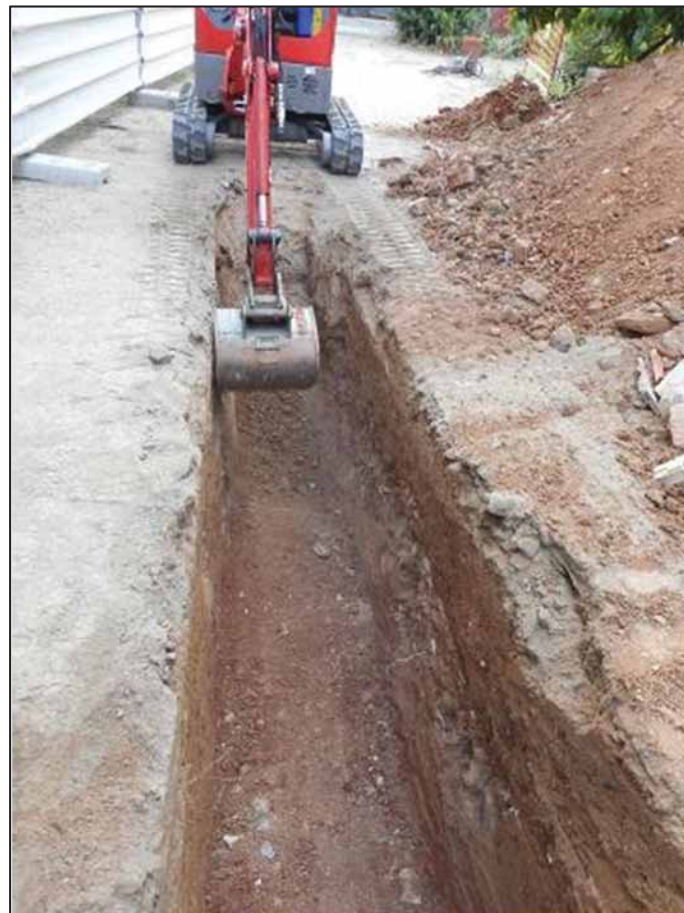
14. Màquina realitzant les tasques de buidat de la rasa.
