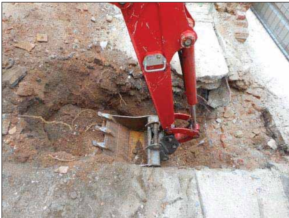
9. Treballs de buidat del segon tram de rasa.
