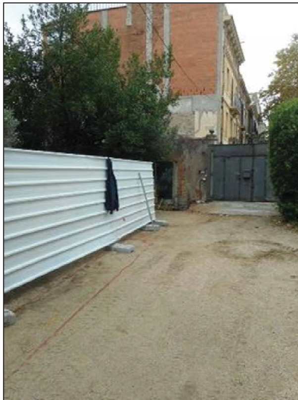
6. Projecció de la rasa dins el pati nord dins el tancat de la Torre Mitjans.
