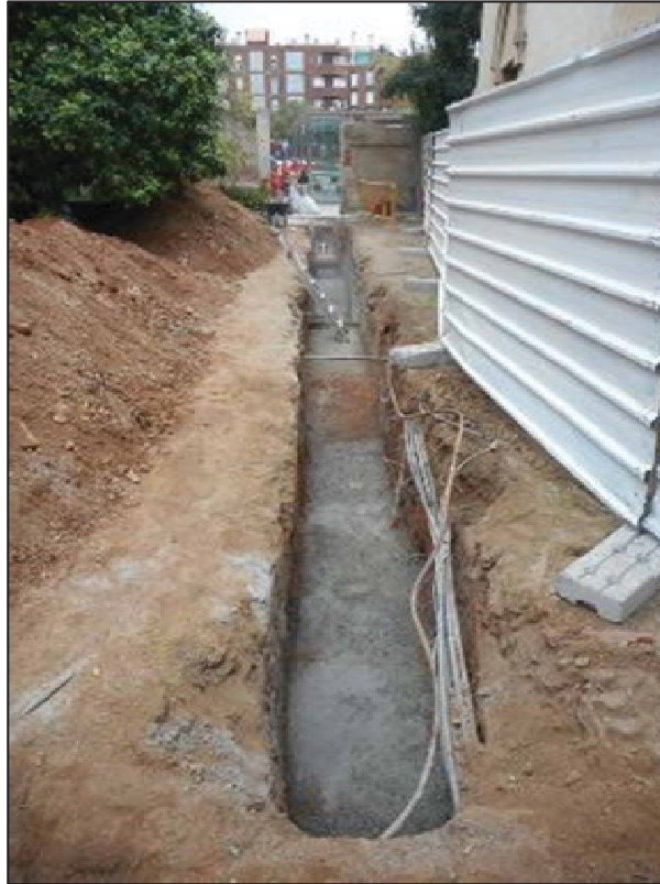
25. Vista de la rasa finalitzada a l'interior de la finca de la Torre Mitjans. Orientació est.
