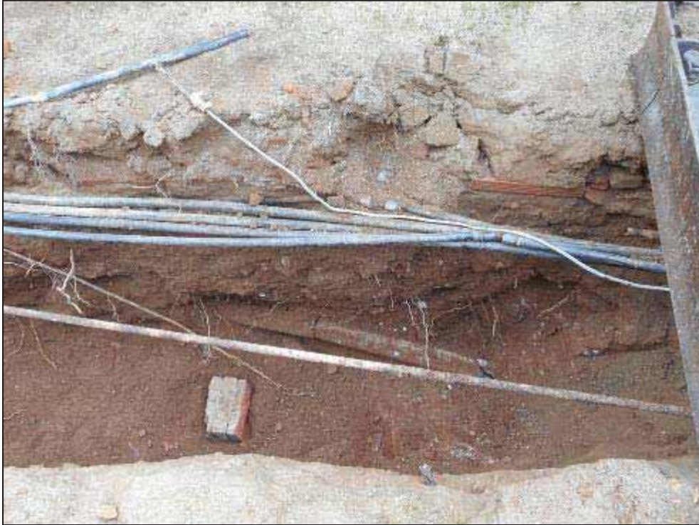
23. Detall dels diferents serveis localitzats al tram final de la rasa, orientació oest.
