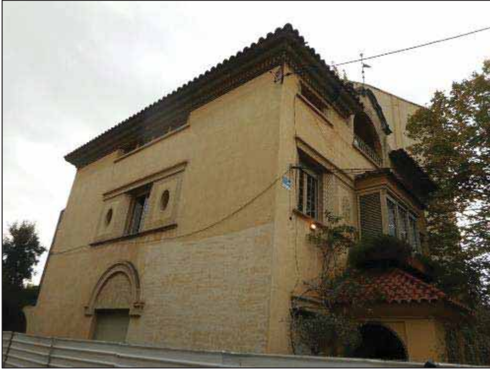
3. Façana nord de la Torre Mitjans.
